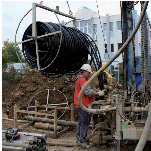
Abb. 7: Einbringen einer Erdwärmesonde (Quelle: LfU)
