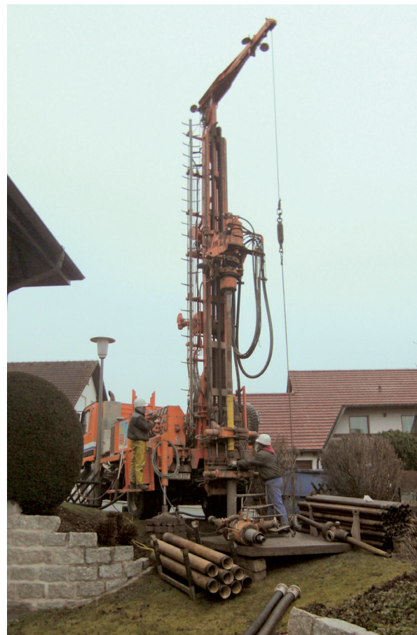
Abb. 1: Bohrung für Erdwärmesonden (Quelle: LfU)
