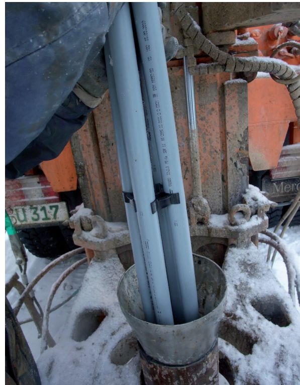
Abb. 8: Einbringen einer Erdwärmesonde mit Innenabstandshalter (Quelle: LfU)
