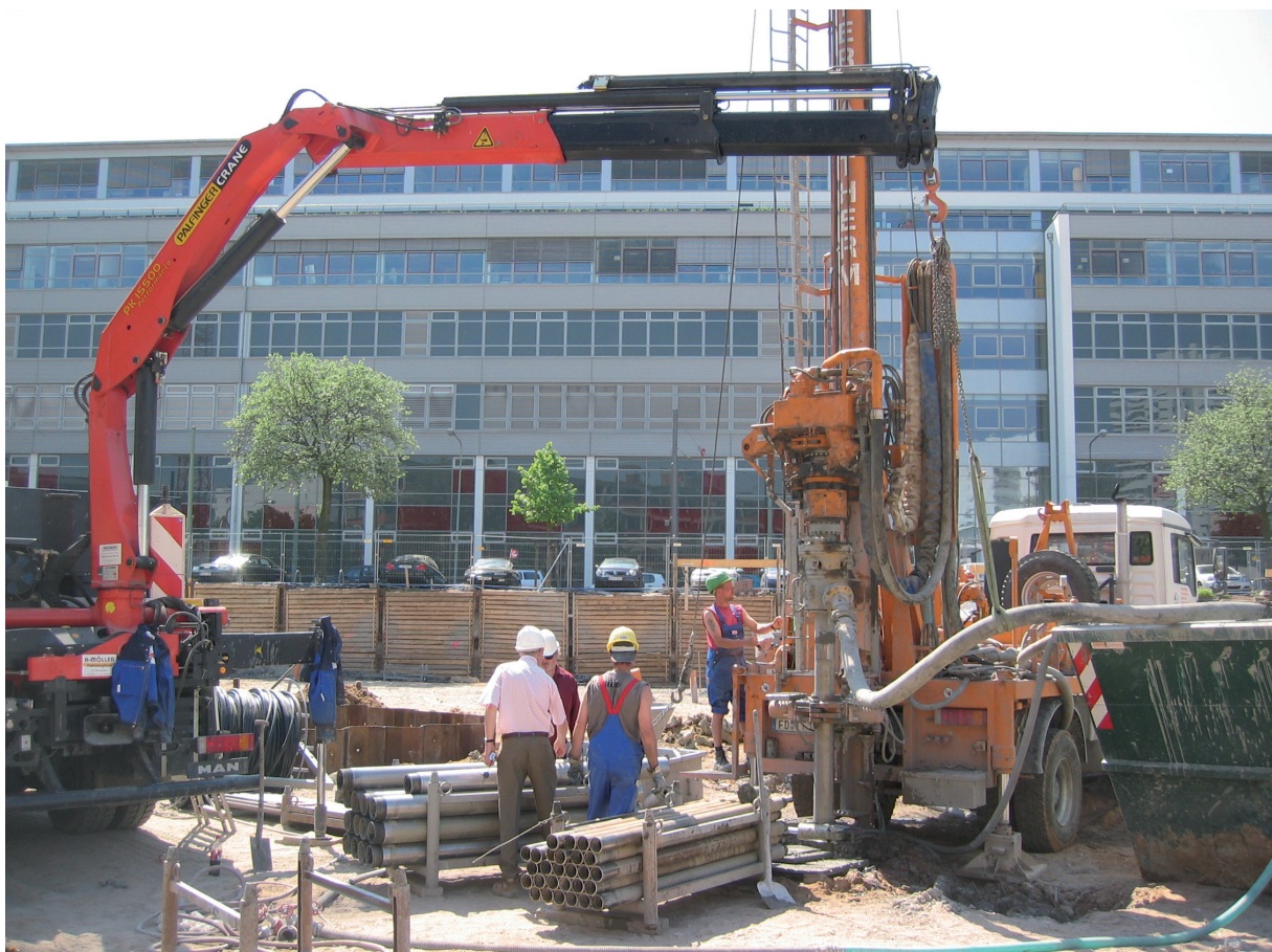
Abb. 2: Bohrung für Erdwärmesonden (Quelle: BWP)
