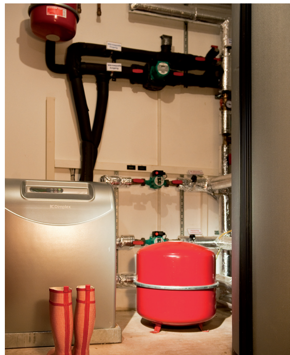
Abb. 10: Wärmepumpenheizung (Quelle: BWP)
