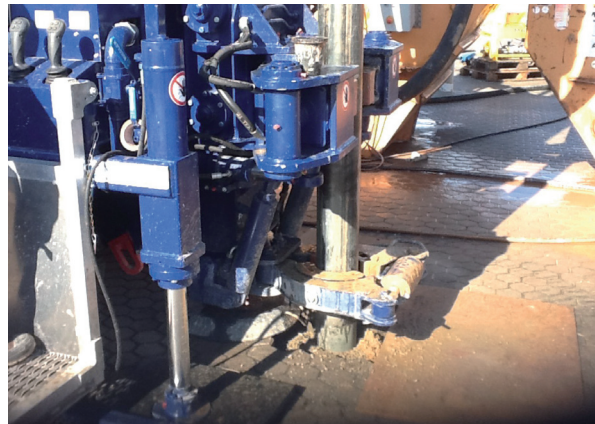
Abb. 6: Bohrung für eine Erdwärmesonde (Quelle: BWP)
