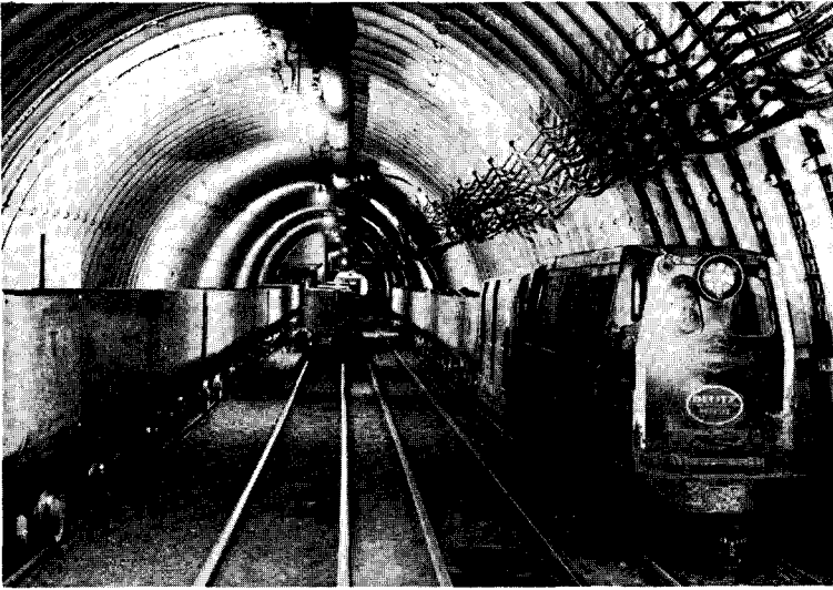
Abb. 5. Lokomotiv-Förderung im Füllort der 1000m-Sohle am Zieglmeierschacht.
