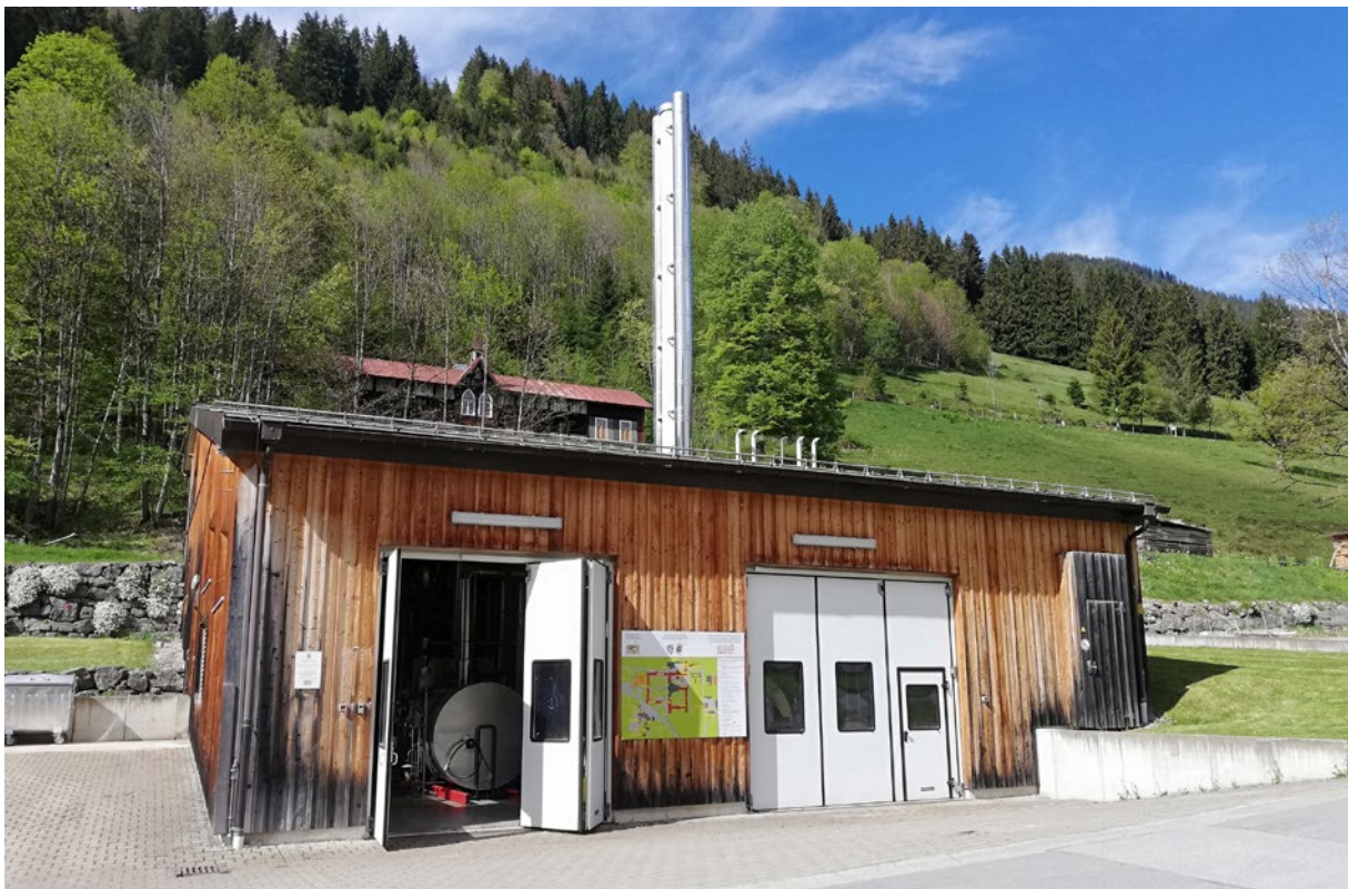
Bayern stärkt die Wärmewende und die regionale Wertschöpfung mit dem Förderprogramm BioWärme Bayern – auch das Kloster Ettal heizt mit heimischen Holzhackschnitzeln
