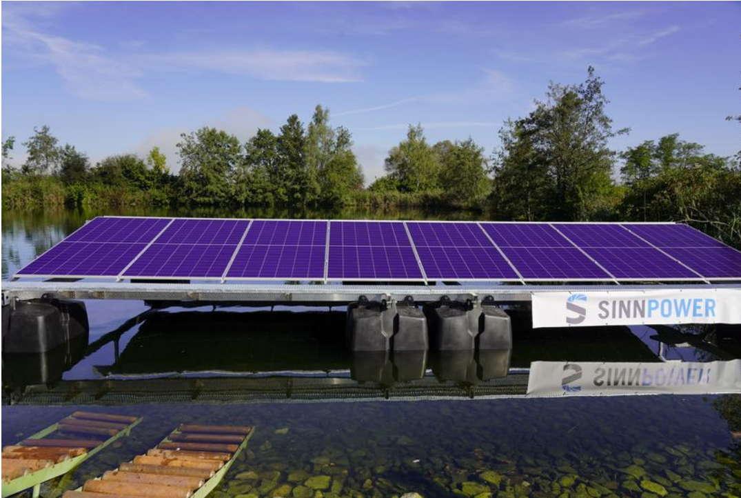
Pilot-Photovoltaikanlage der Firma SINN Power GmbH auf einem Klärteich Foto: StMWi
