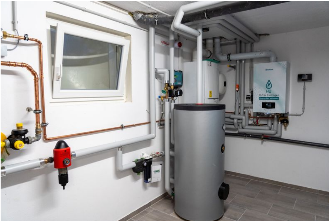
Die hochmoderne Wasserstoff-Brennwerttherme mit Pufferspeicher eingebaut im Keller eines Wohnhauses. Foto: StMWi/E. Neureuther
