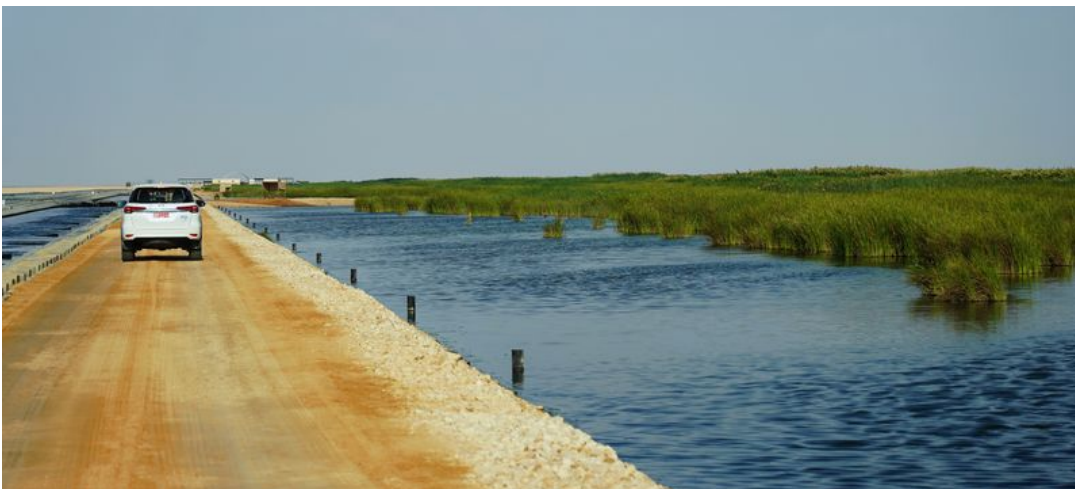
Das zu reinigende Wasser fließt über einen Höhenunterschied von nur drei Metern durch abgestufte Klärbecken. Foto: StMWi/T. Assenbrunner
